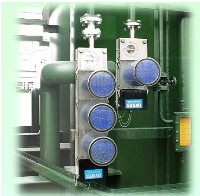
■ SC型環境調和ブリーザ 大気の吸湿呼吸器で、変圧器のコンサベーター内へ流入する大気をシリカゲルを使って湿度調整します。再生型エコブリーザーです。
